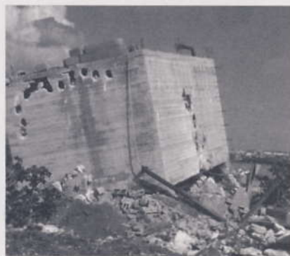
Zerstörter Wassertank von Ezbet-Salman
